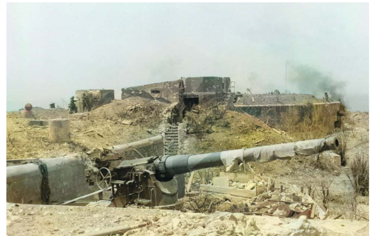
Мыс Фиолент, руины 18-ой батареи, июль 1942 г.
